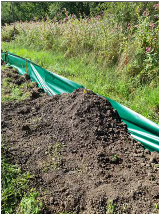
Foto Überstiegshilfe: Von der Eingriffsseite her müssen die Zäune von Echsen übersteigbar sein; diese Erdwälle wurden etwa alle 10 m errichtet und reichen bis zur Zaunoberkante.
